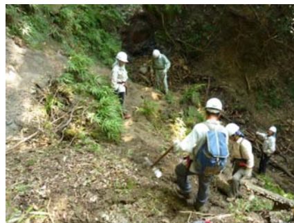
中央道 沢付近崩壊地仮補修
