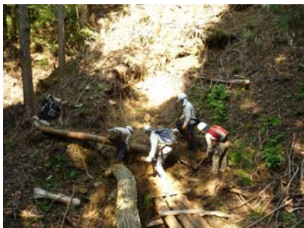
七曲り下 崩壊地仮補修
