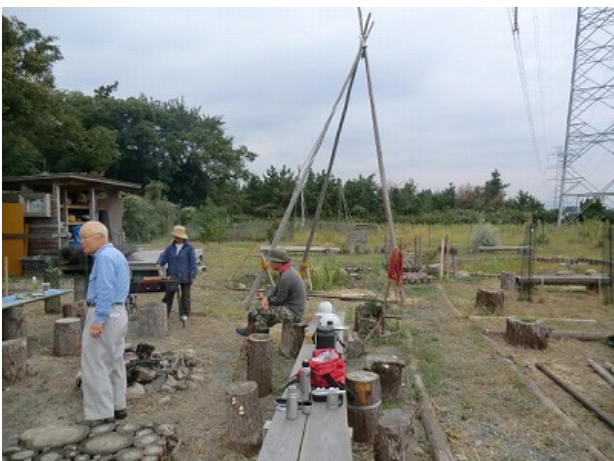
後ろに見える三角の足場で井戸掘りです。
