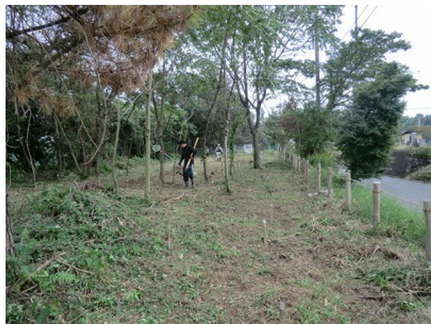
植栽のための仮クイも 170 本ほど打ちました。
