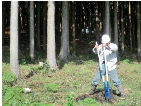
標柱の穴掘りですが石が多いようです。
