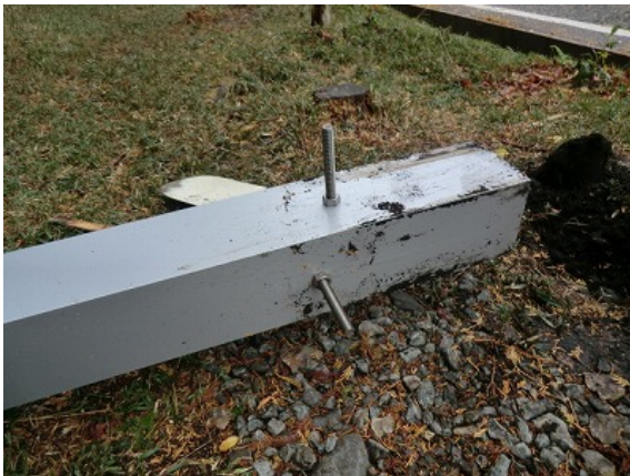
ボルトの設置
