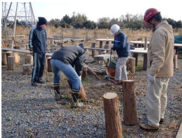
円テーブルの脚設置
