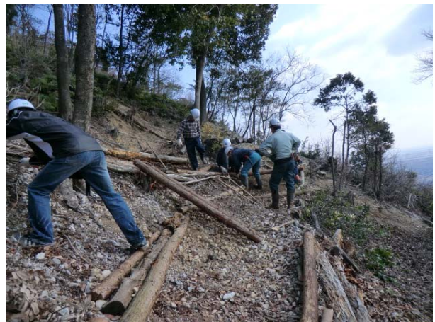
間伐材のヒノキを運んでの歩道整備
