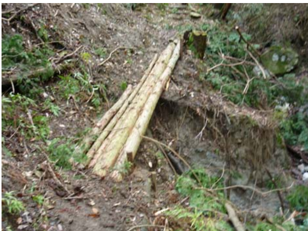
崩壊場所に橋を架けて修復
