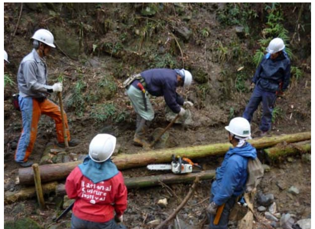
歩道修復場所で邪魔になる石を掘り起こしている松永さんを見守っている
