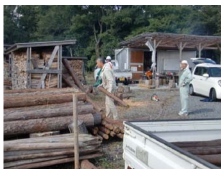
杭と間伐材の整理
