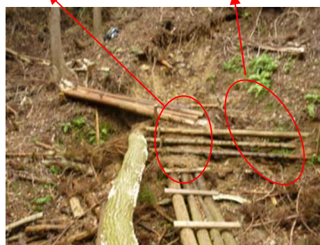
七曲がり下崩壊地補修完了
