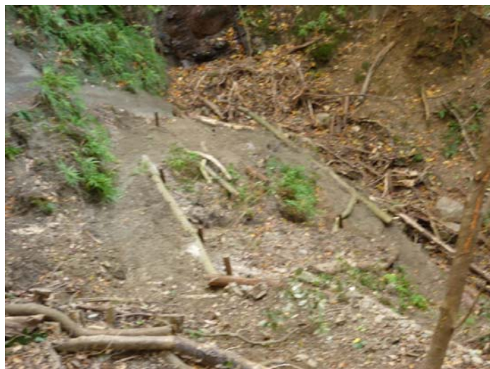
中央歩道 大崩壊地の補修完了
