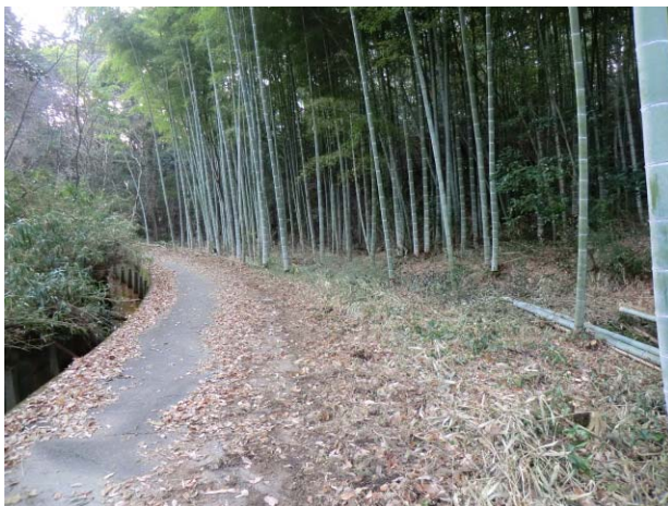
上流部の整備後
