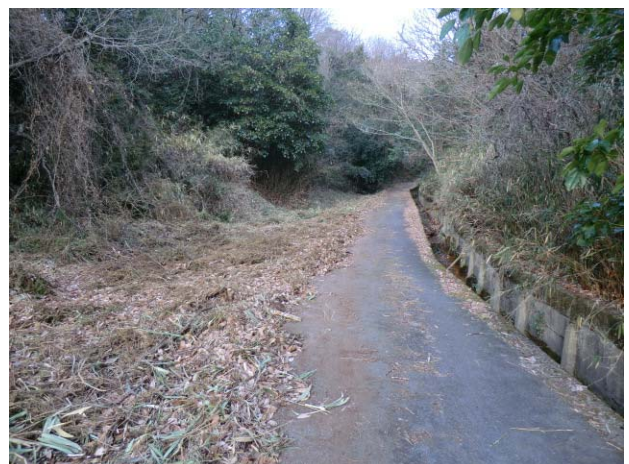
最下流部の整備後
