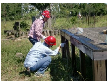
デッキの防臭塗装
