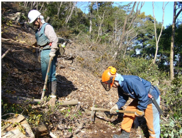
歩道作成作業状況
