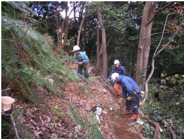
作業歩道整備作業状況
