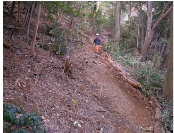
概成された作業歩道
